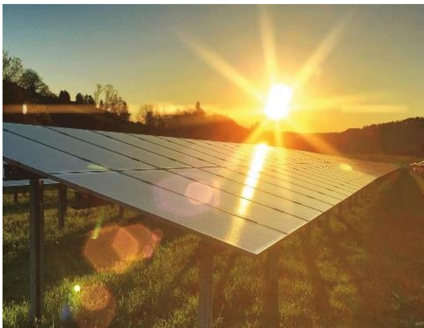
Рисунок 2 – Установка солнечных батарей
