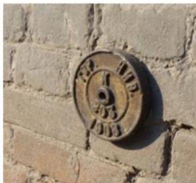
Рисунок 1.13.4 – стенная марка
