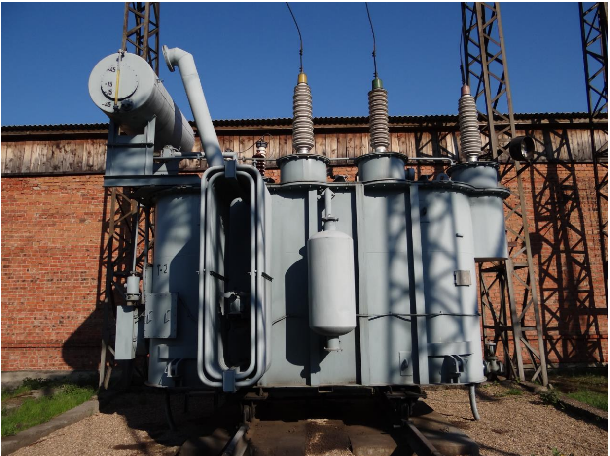
Рисунок 4 – Силовой трансформатор с системой охлаждения типа Д
