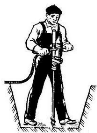
Рис. 61 Погружение в грунт вертикальных электродов заземления: а – ввертыванием электросверлилкой; б – забивкой электрическим вибратором, питаемым от автомобильной электростанции.
