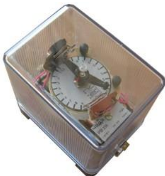
Рисунок 4.10- Реле времени с часовым механизмом типа РВ-238
