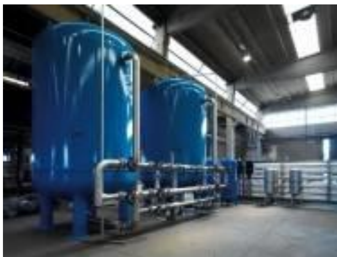
Рисунок 1 – Установка адсорбционный фильтр для очистки воды, разработанный Саратовским ГТУ им. А.А. Гагарина [5]
