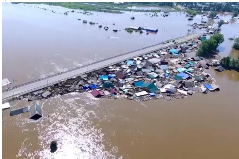
Рисунок 1 – Мост через р. Ию во время наводнения 2019 года
